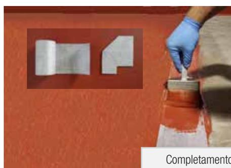
Completamento delle finiture, dei giunti e degli angoli con **velajoint band angle**
