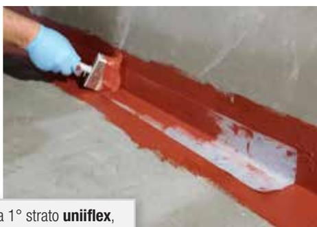
**Bordi:** stesura 1° strato **uniiflex**, posa **velajoint band** e stesura 2° strato **uniiflex**
